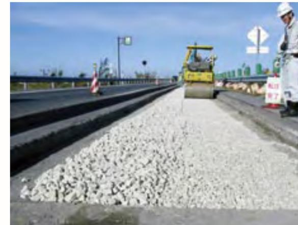
既設道路の沈下抑制
