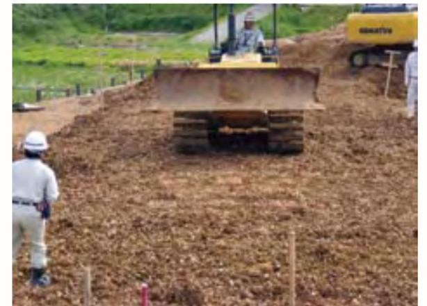
新設道路の沈下抑制（混合土）
