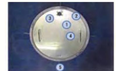
①中蓋 ②受枠 ③ロック装置(シリンダー錠内蔵) ④取手 ⑤アンカーボルト(衝撃吸収ゴム付き)
