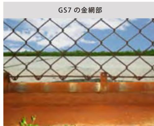
亜鉛メッキ鉄線で最上位品質である亜鉛メッキ鉄線(S)7種(GS 7)を使用しても6年で鉄線が錆び7年目で取替を実施しています。
